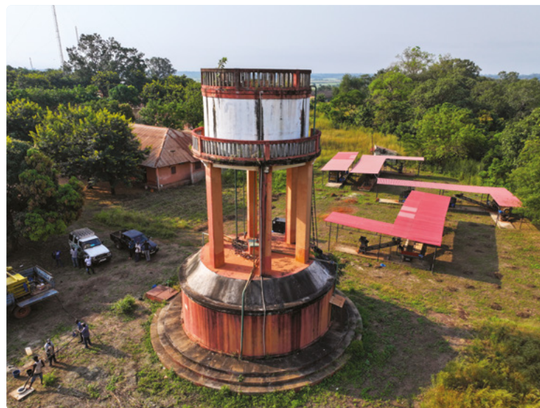
Reservatório de água em Bafatá
