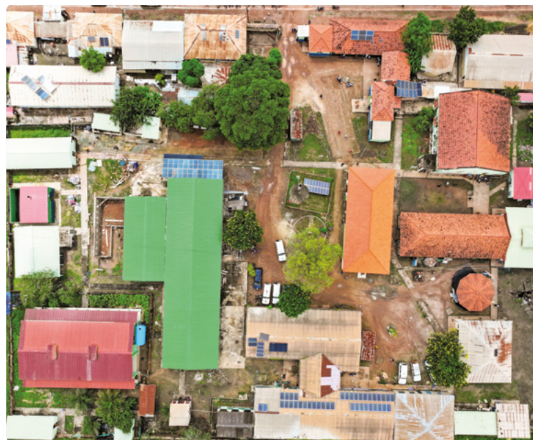
Fotografia aérea das obras de requalificação e construção do Hospital Regional de Gabu
