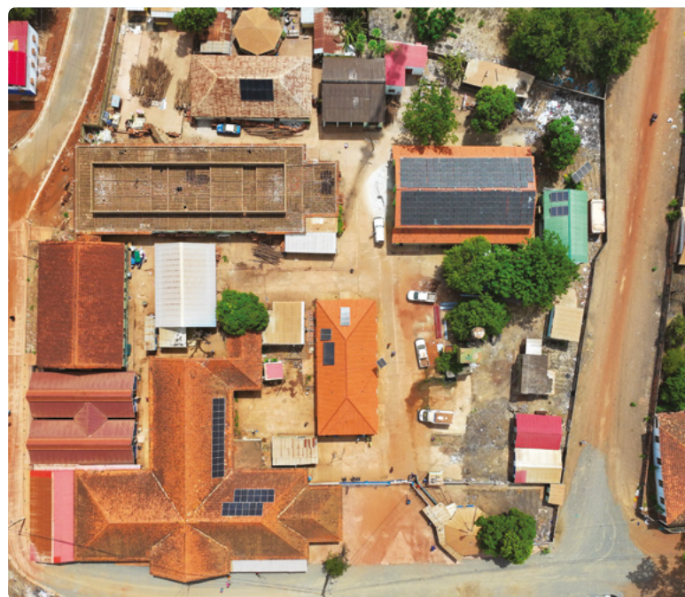
Fotografia aérea das obras de requalificação do Hospital Regional de Bafatá
