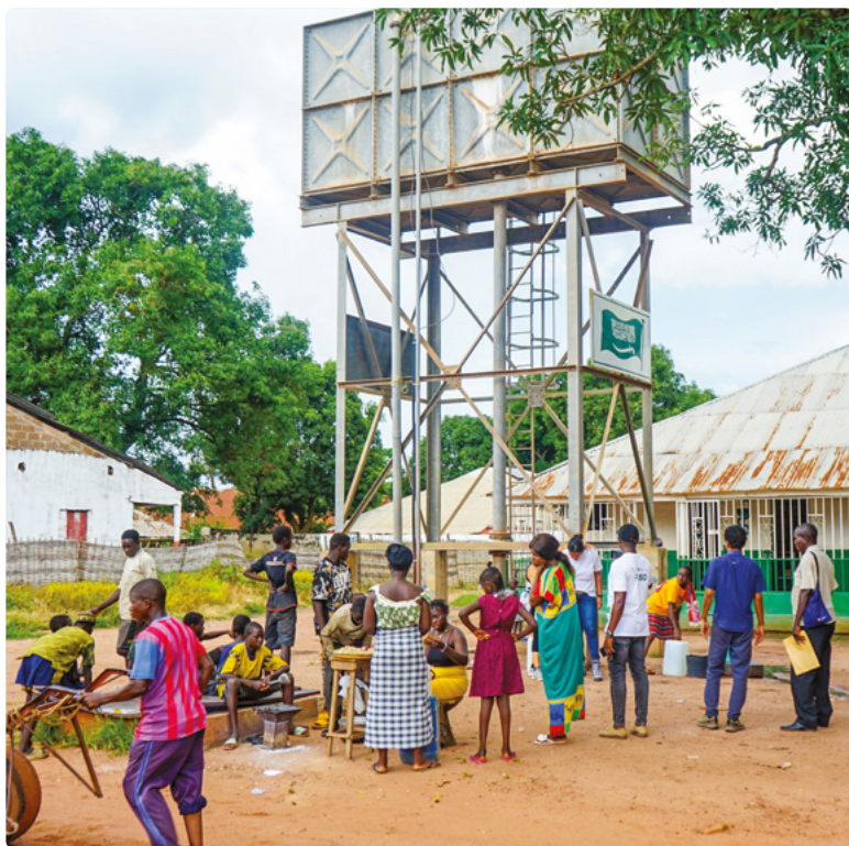
Furo de captação e armazenamento de água em Gabu
